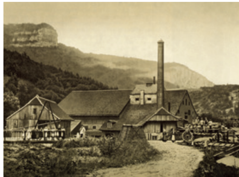
Die Entstehung von Industrieunternehmen bildeten den Hintergrund für die Gründung der Solothurner Handelskammer. Das Werk Klus der von Roll'schen Eisenwerke im Jahr 1874. ZB Solothurn, FS_P_07754.
